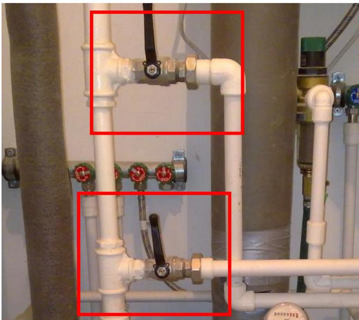
В период отключения горячей воды трубы остывают и уменьшаются в диаметре на доли миллиметров. Из-за этого может нарушаться герметичность соединений, что приводит к образованию течи или капания воды.
